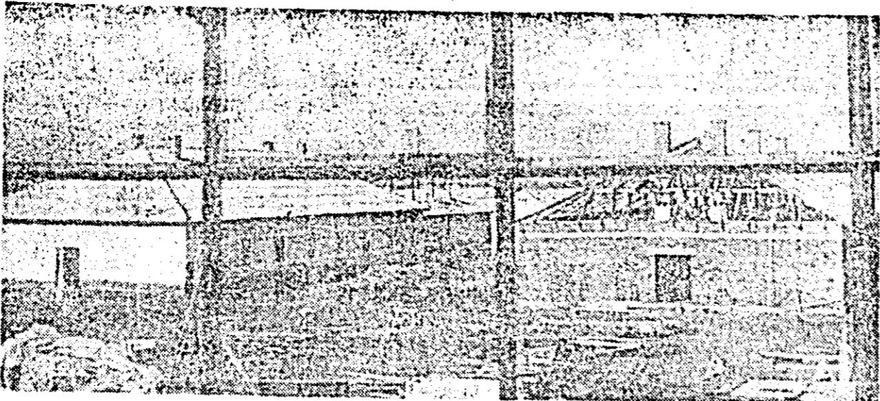
Noi construcții de locuințe la I.A.S. Fintinele. Foto: V. MOTOCEA
