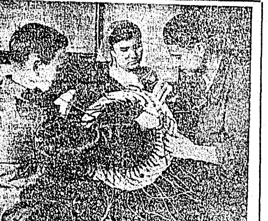
ÎN CLIȘEU: Elevii Francisc Weininger, Terezia Haiduc și Pavel Pușta fac legăturile la motorul rebobinat. Este una din ultimele operații.
