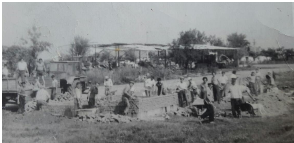
Construcția actualei baze sportive
