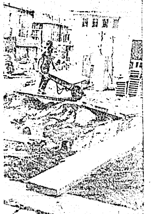
„N-avem suficientă forță de muncă”, spun constructorul. Imaginea alăturată prezintă o replică concretă la acest răspuns. Volumul mare de lucrări nemecanizate însoțeste forța de muncă pe șantier.
