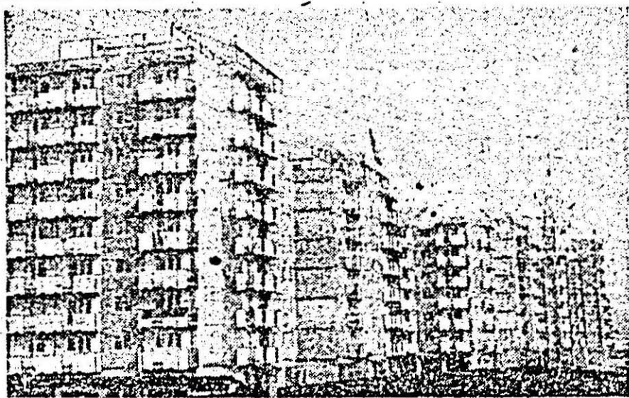
Blocul nou de locuințe în cartierul Micălaça.
