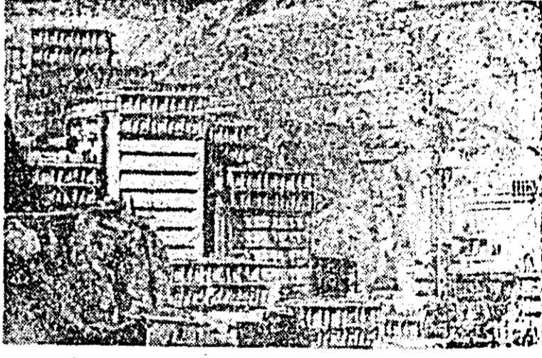
R.P. BULGARIA. Cel mai mare baraj hidroenergetic din Bulgaria, înalt de 144 m a intrat în construcție în munții Rodope. Aici urmează să se creeze un lac artificial cu câteva sute de milioane de metri cubi de apă pentru hidrocentrala „Antonivanov”. IN FOTO: vedere asupra construcției barajului hidrocentralului „Antonivanov”.
