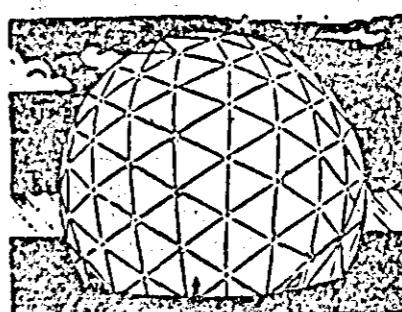
Sfera luminoasă din fotografie este o clădire gigantică din masă plastică armată cu fibre de sticla. Această clădire este concepută din elemente pre-fabricate și are avantajul că este ușoară, se poate asambla și destaca ușor și se poate transporta într-un alt loc, este neînflamabilă și nu se teme de perturbații atmosferice. Clădirea este calculată să reziste la o viteză a vîntului de 240 km pe oră.
