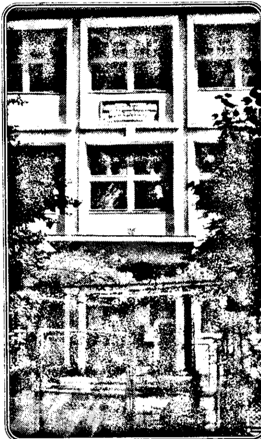
Liceul Gurahont se află în faza de reparații. Sperăm că nu vor fi uitate grupurile sanitare, unde situația e „albastră”.
