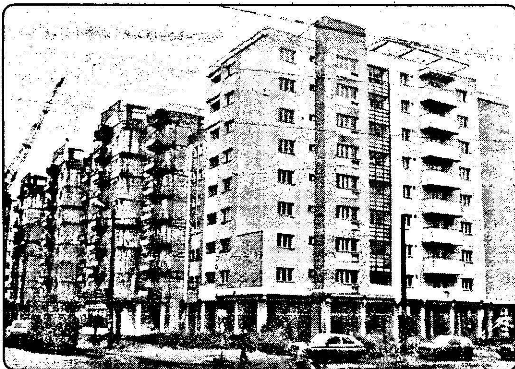
Scara D a blocului nr. 6 de la Fortuna va fi dată în folosință familiilor de petroliști.
