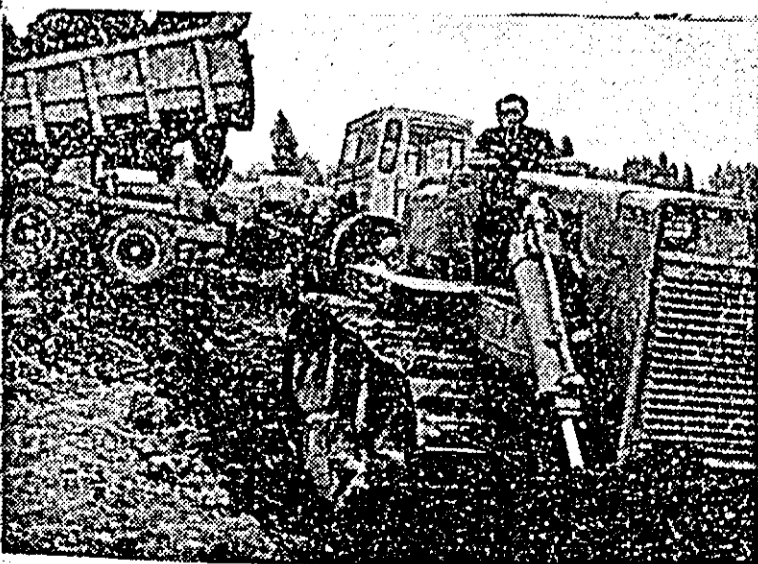
Harnicii mecanizatori de la T.C.I.F. folosesc din plin capacitatea utilajelor la consolidarea digului Mureşului.
