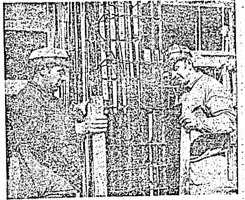
Destolăcia dulgherilor din echipa condusă de Ioan Duma o dovedește calitatea superioară a lucrărilor pe care le execută.
