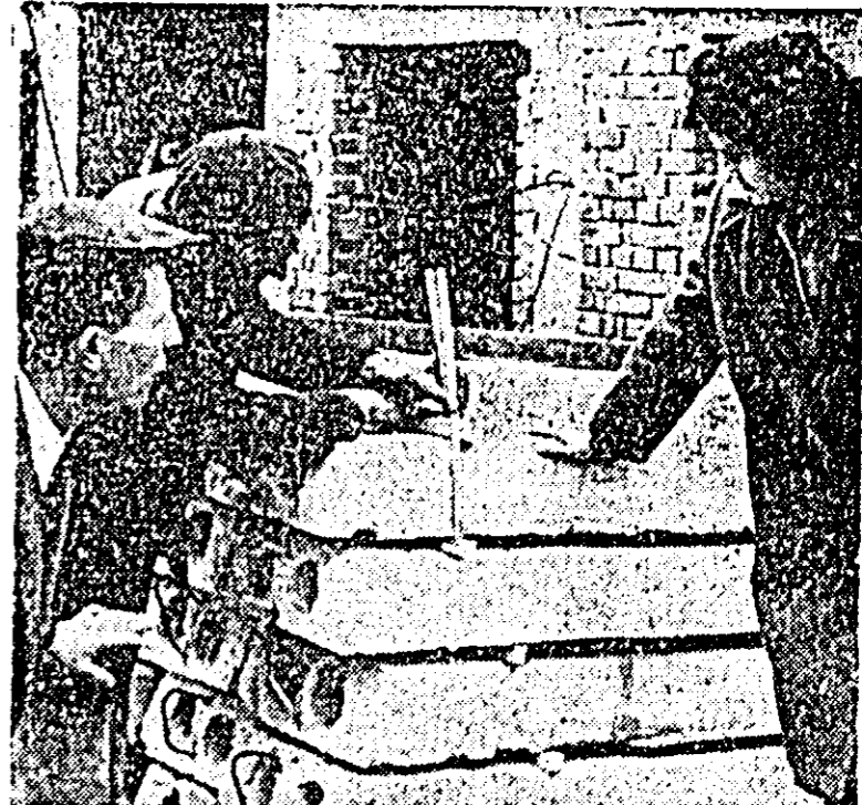
Ceea ce în cadrul unei simple discuții putea fi contestat, aici, pe șantier, în fața probelor evidente, rămîne fapt cert. Unele plăci din fibro-beton nu numai că nu rezistă la trecerea peste ele dar se fărîmîțează chiar cînd le lei în mîna. Cei care, în clișul alăturat, dovedesc acest lucru furnizorului sînt maestrul Veturia Stăncioiu și ing. Ioan Korek (clișul de jos).
