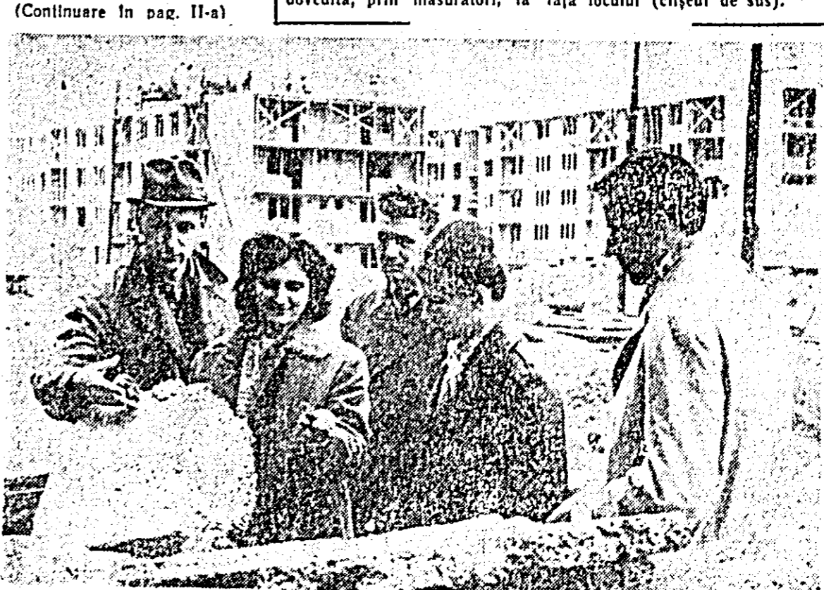
Ceea ce în cadrul unei simple discuții putea fi contestat, aici, pe șantier, în fața probelor evidente, rămîne fapt cert. Unele plăci din fibro-beton nu numai că nu rezistă la trecerea peste ele dar se fărîmîțează chiar cînd le lei în mîna. Cei care, în clișul alăturat, dovedesc acest lucru furnizorului sînt maestrul Veturia Stăncioiu și ing. Ioan Korek (clișul de jos).
