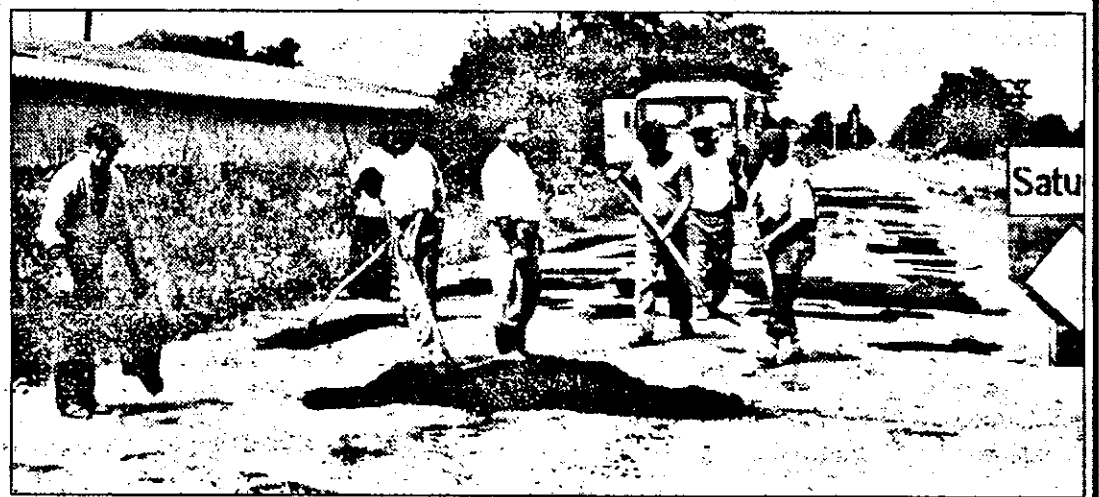
Reparații la drumul Satu-Nou - Apateu.
