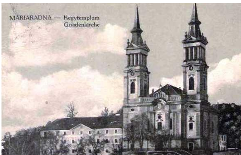
Foto48.Mănăstirea Maria-Radna,după reconstrucția din 1911, când s-au înălțat cu 30m turnurile
