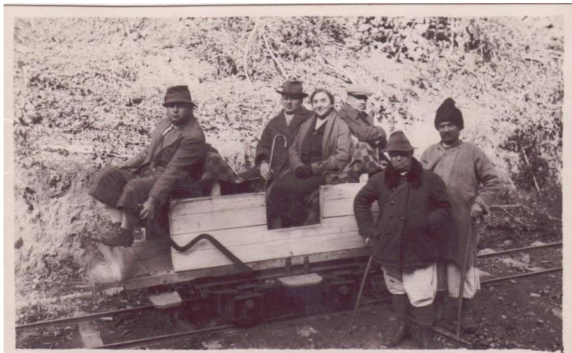
Foto 53. Vagonet pentru transportul muncitorilor-echipa de întreținere a liniei
