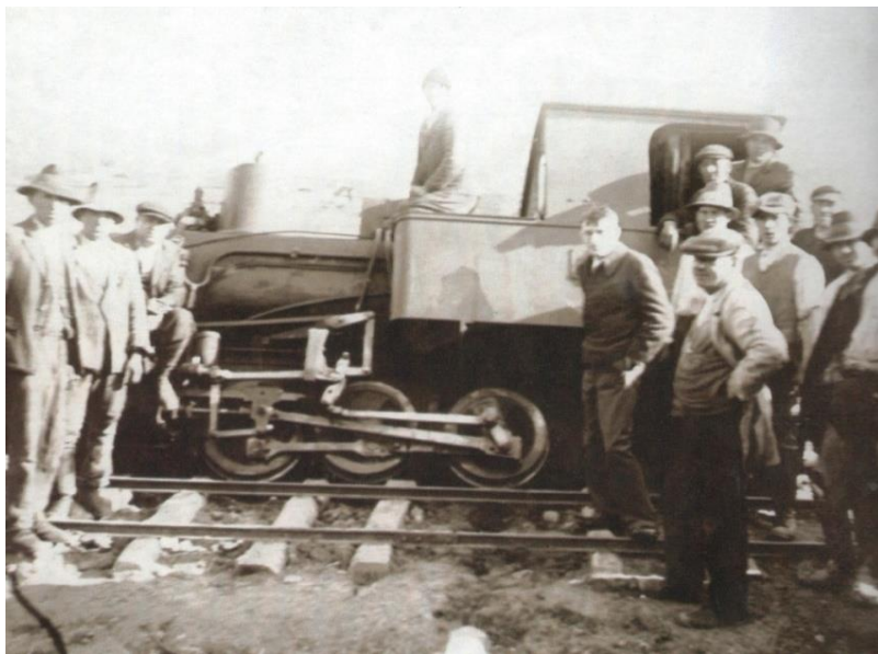
Foto 42. Locomotiva de tip O&K deraiată în traseu. Se vede simplitatea construcției liniei și infrastructura terasamentului
