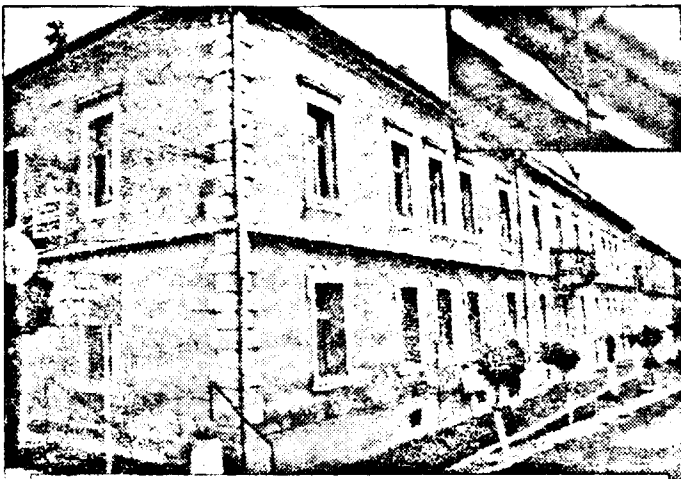
Clădirea liceului „Atanasie Mariescu” din Lipova, în prag de... prăbușire
