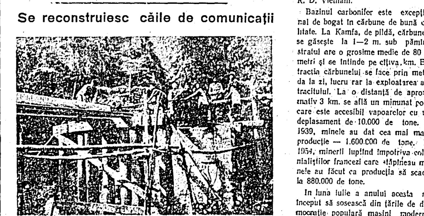
Poporul vietnamez muncește cu eroism la refacerea industriei, comunicațiilor și telecomunicațiilor. ÎN CLISEU: lucrările de reparație a unui pod.
