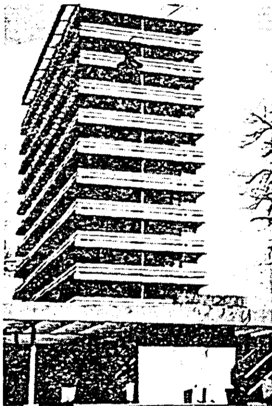
Profiluri arhitectonice arădene. Foto: ȘT. I. SIMON
