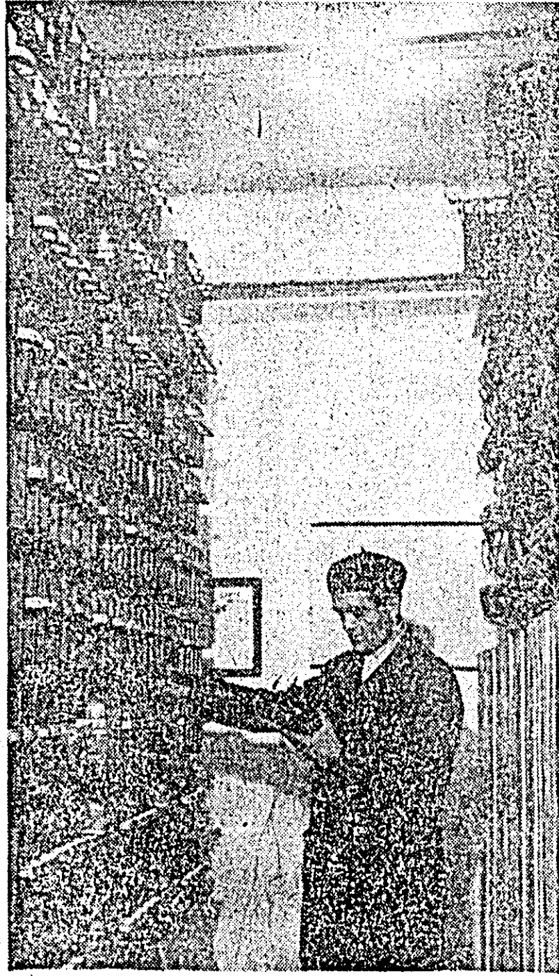
Siguranta circulatiei în Stația CFR Arad depinde în mare măsură de funcționarea instalației de centralizare electrodinamică. De aceea ea este verificată și întreținută în cele mai bune condiții. Fotografia noastră redă un aspect din timpul controlului în sala de relece a sectorului de centralizare electrodinamică. Controlul îl efectuează electromecanicul Ioan Gündör, șef de tură.
